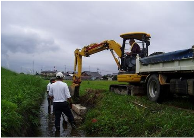
土手と石の隙間にダンプからすくった砂利を詰めています。うまいもんですね
