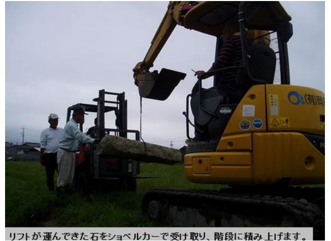
リフトが運んできた石をショベルカーで受け取り、階段に積み上げます。
