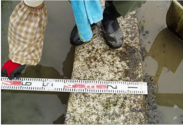
階段の一番下の石材は、安定感が出るよう長く幅広の石材とした。この日の作業は、一番下の石材を2カ所おいて終了とした。
