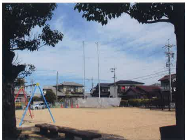
移設したブランコから見た「竜宮さん」の建設現場
