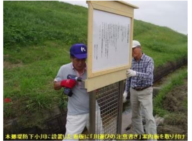
本郷堤防下小川に設置した看板に「川遊びの注意書き」案内板を取り付け
