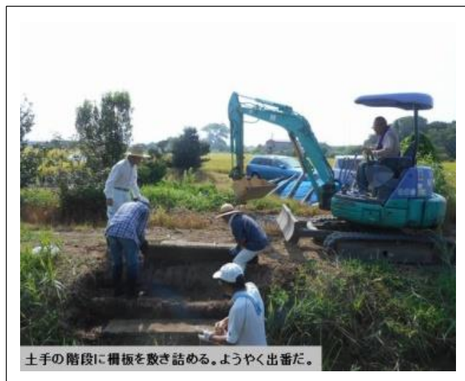
本郷川遊びのため、子どもが川に入りやすいように、ショベルカーを使って階段を付ける作業に着手。
