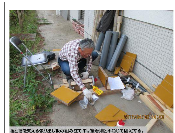
塩ビ管を支える張り出し板の組み立て中。接着剤と木ねじで固定する。
