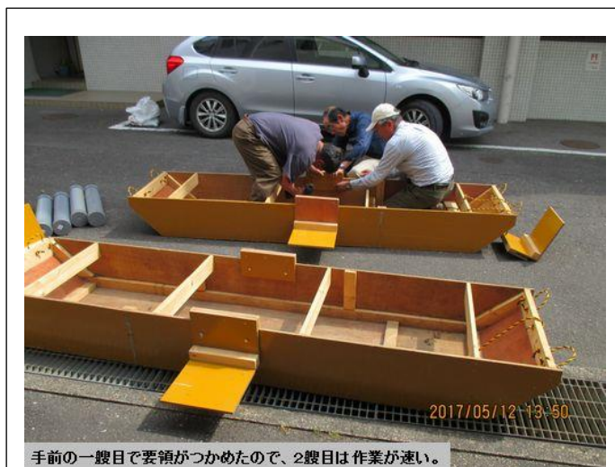
手前の一艘目で要領がつかめたので、2艘目は作業が速い。
