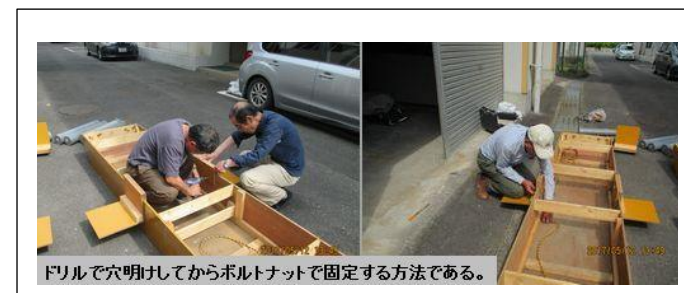
塩ビ管を支える張り出し板の組み立て中。接着剤と木ねじで固定する。
