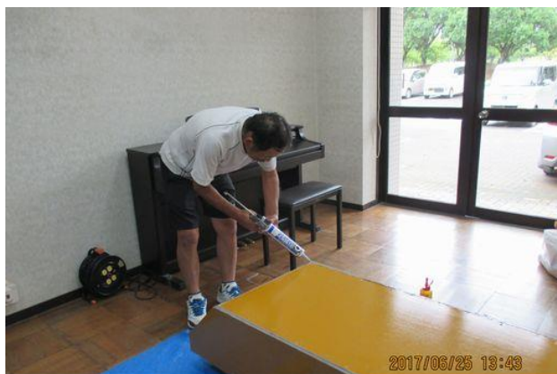
木工ボンドと木ねじで水密と強度を持たせているが、ボンドおよびコンパネ端面防護のため、シリコンシーラントを上塗りした。
